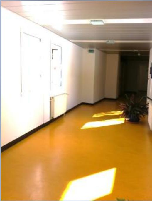
Auf Höhe der Pflanze im Gang resp. der Notfallausgangshinweis markieren den Übergang von konventioneller Bauweise zum Modul. Heizung und Fenster sind bereits Modulbauweise. Durch die einheitliche Gestaltung ist kein Unterschied zu bemerken.
