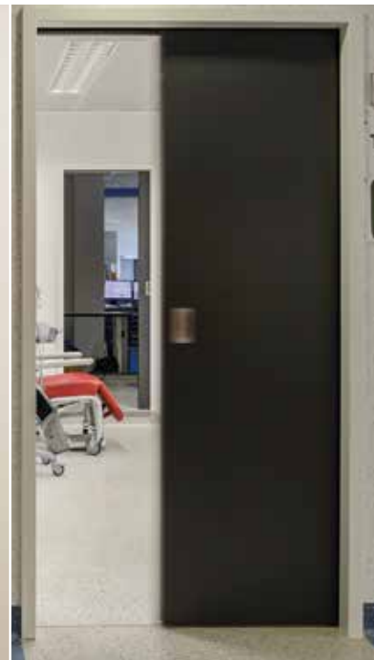
UZ Antwerpen RF30 geautomatiseerde inbouwschuifdeur
