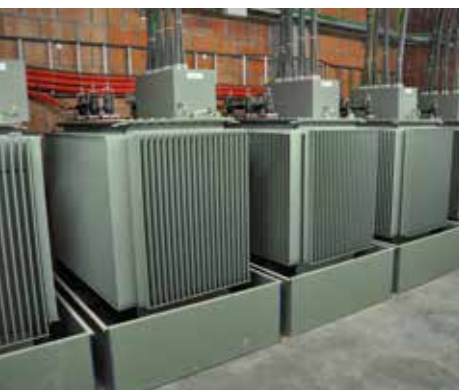
Transformatorcentrale 12kV
