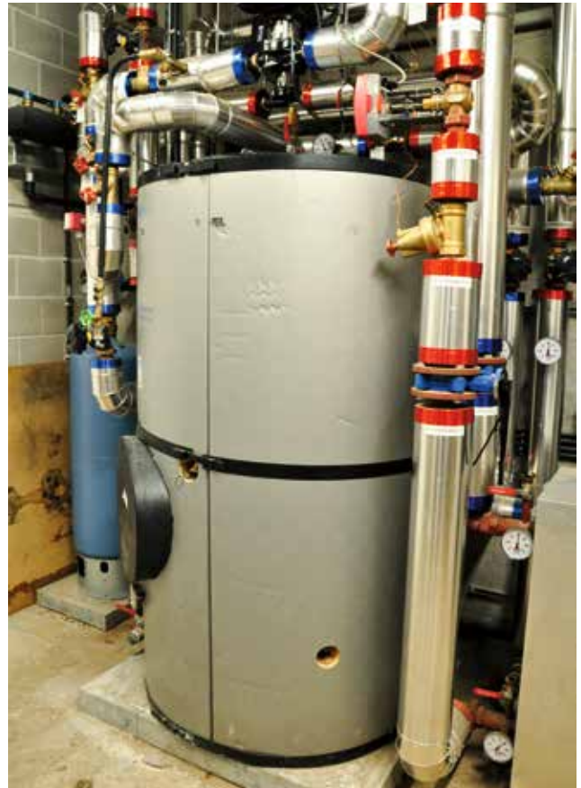
De productie van sanitair warm water gebeurt via verschillende onderstations. Duidelijk zichtbaar is de evolutie in technieken tussen de oudste en de nieuwste installatie.
