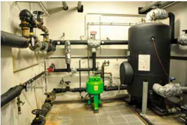
De productie van sanitair warm water gebeurt via verschillende onderstations. Duidelijk zichtbaar is de evolutie in technieken tussen de oudste en de nieuwste installatie.
