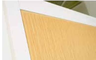
ZH Maas en Kempen Maaseik Foto boven: RF30 schuifdeuren met PU kantlatten en glaslatten voor operatie kwartiers Foto onder: RF30 draaideur met bovenlicht en PU kantlatten
