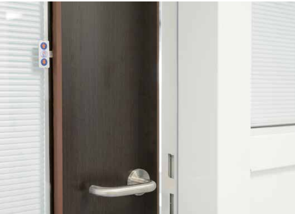
ZH Maas en Kempen Maaseik | RF30 draaideur met PU kantlatten en glaslatten, zijlicht (beglazing met lamellen, elektrisch bediend)
