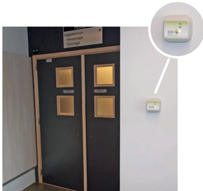
Online systeem: toegang tot een bepaalde verpleegeenheid. Deze is afgesloten binnen bepaalde uren, alleen personen met een badge kunnen dan binnen.
