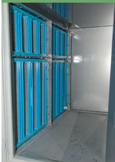
GEA Delbag compactfilters worden steeds in glasvezel uitgevoerd in een CAIRplus hygiëne luchtgroep
